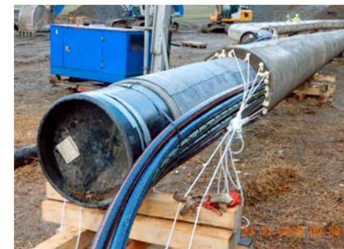
Rohrleitung DN 500 mit Leerrohren und Ballastierung
