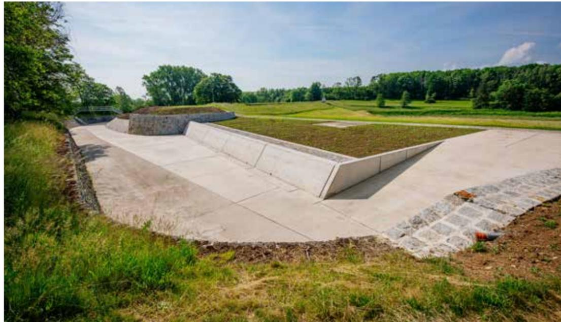
Blick auf das Hochwasserrückhaltebecken mit neuem Überfall, Stützmauer und Stahlbetonsohle
