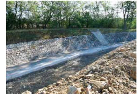
Abbruch des bestehenden Überfalls, einer Seite der Böschung und der halben Stahlbetonsohle
