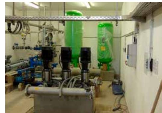
TO3 – Neue Druckerhöhungsanlage PW Trünzig, im Hintergrund Druckkessel (03.11.2020)
