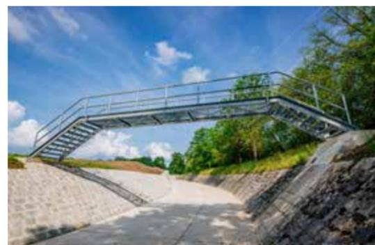
neu errichtete Böschung, halbe Stahlbetonsohle und Brücke
