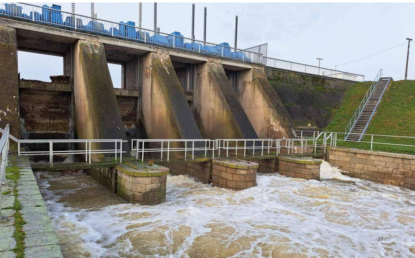
Ein weiterer Schwerpunkt der Hochwasserlage konzentrierte sich auf den Süden Thüringens. Durch die Talsperre Schönbrunn konnte bis zum Vollstau das Wasser zurückgehalten werden. Das HRB Ratscher wird im Verbund mit der Talsperre Schönbrunn gesteuert. Beide Anlagen hielten durch den Einstau zusammen insgesamt 5,6 Millionen Kubikmeter Wasser zurück. Das führte zu einer Reduzierung des Hochwasserscheitels der Schleuse. Die Talsperre Schönbrunn reduzierte die zufließenden 17,3 Kubik-
