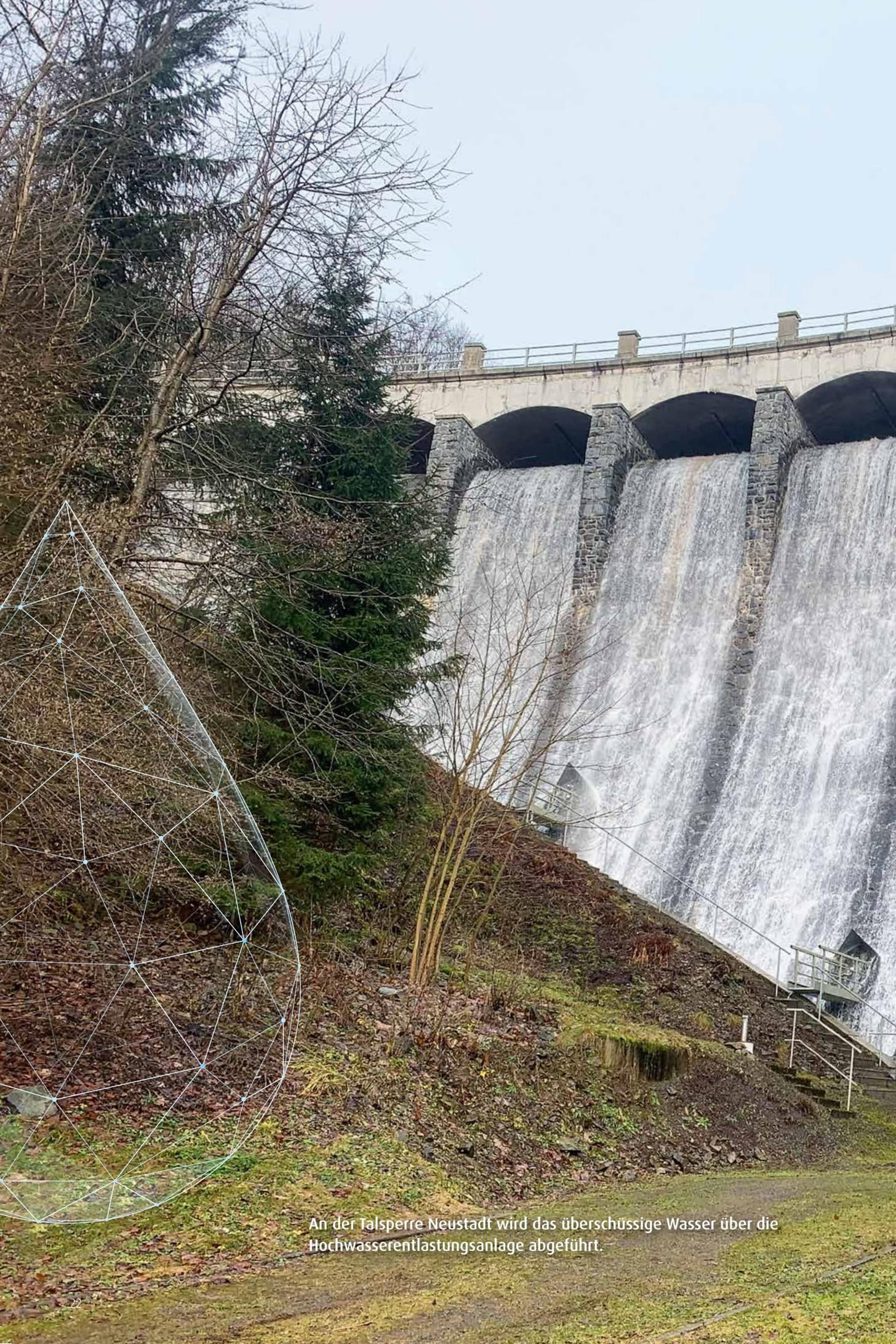
An der Talsperre Neustadt wird das überschüssige Wasser über die Hochwasserentlastungsanlage abgeführt.
