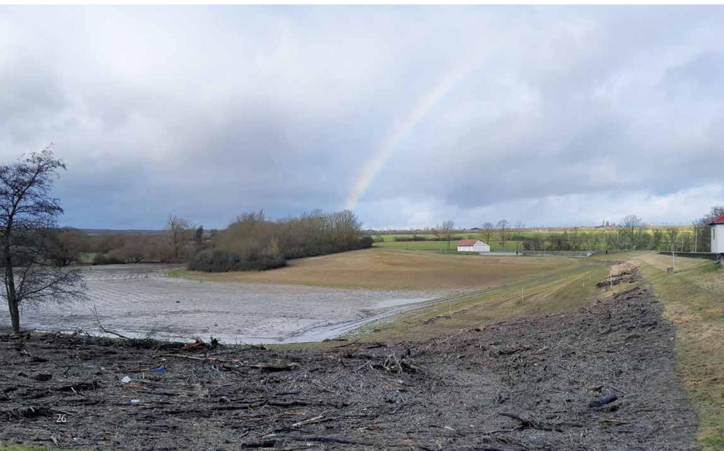
Das HRB Mengelrode wurde ebenfalls dreimal kurzzeitig eingestaut. Jeder Einstau brachte erhebliche Mengen Schwemmgut und Sediment mit, welche gleich im Anschluss beräumt werden mussten.
