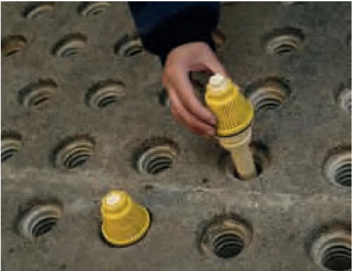
Installation neuer Filterkerzen in der Trinkwasseraufbereitungsanlage Zeigerheim
