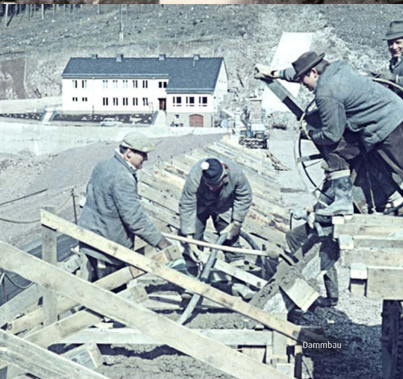
Blick in den zukünftigen Stauraum
