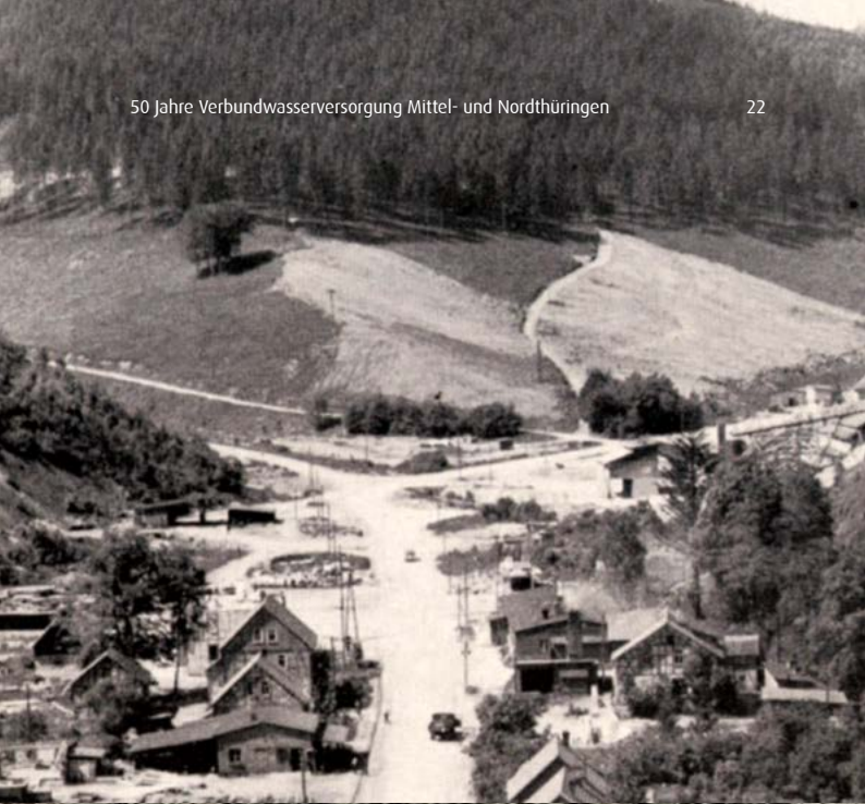
Rückbau der Häuser im zukünftigen Stauraum
