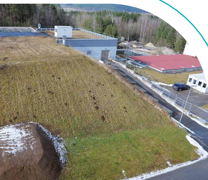
Freigelegte Behälterdecke des Reinwasserbehälters III. Hier soll die neue Filterhalle errichtet werden © TFW/Volker Heuschkel
