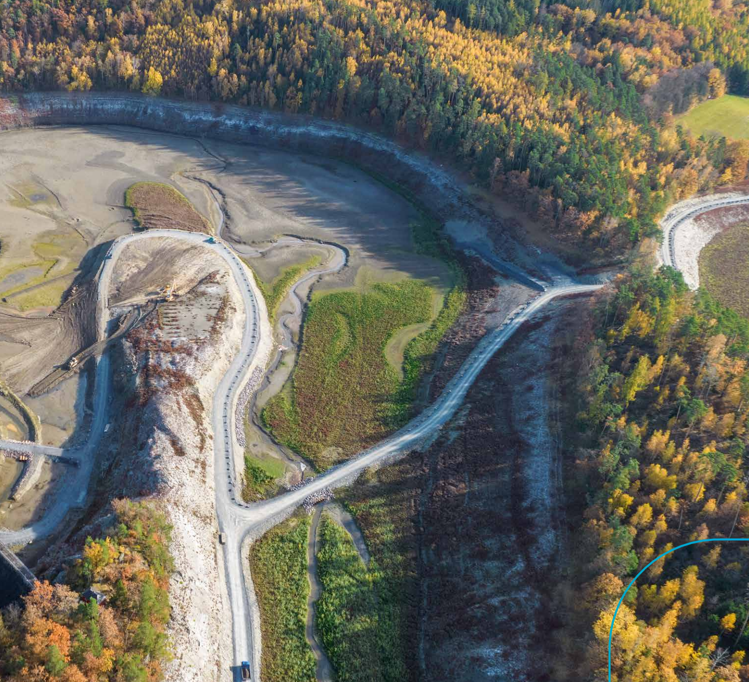
Blick auf die beiden Absperrbauwerke der Talsperre Weida, nach erfolgtem Abstau der Stauanlage im November 2025 © Marcus Daßler
