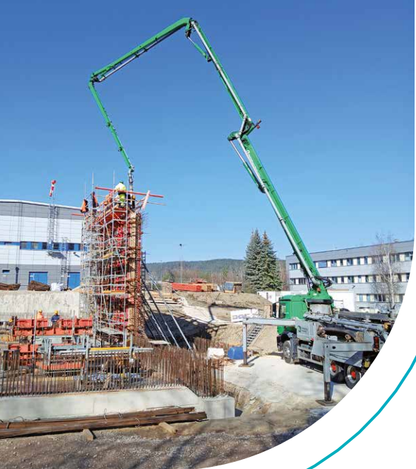
Betonierung Behälterwände RWB II Zeigerheim © TFW/Volker Heuschkel
