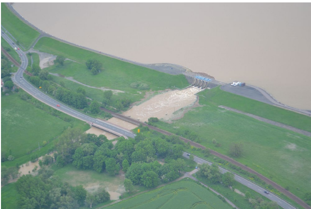
Bild 2: Hochwasserereignis 2013 am HRB Straußfurt
